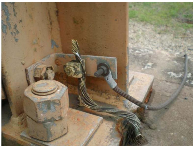
Figura 45 - Interligação da torre à malha de aterramento
