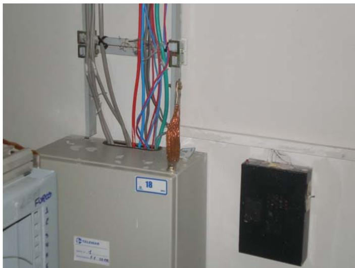
Figura 23 - Detalhe da conexão da esteira metálica com o bastidor de e equipamentos
