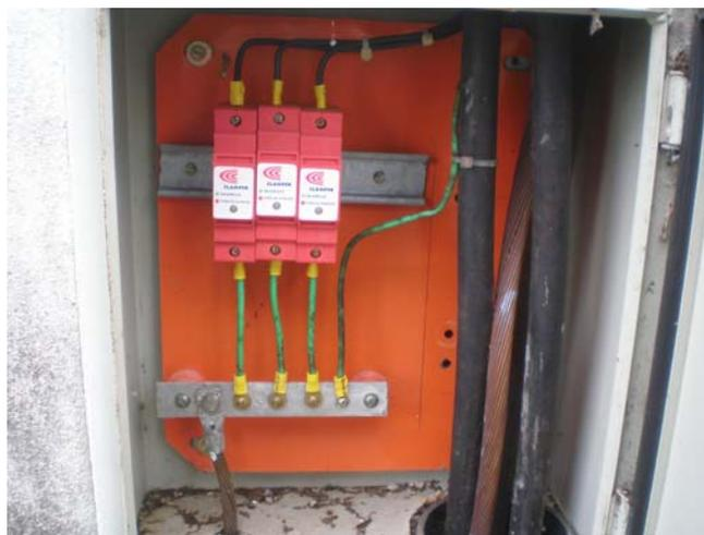
Figura 13 - Instalação dos protetores primários no Padrão de Energia Elétrica
