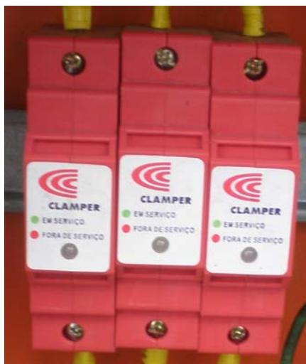
Figura 7 - LEDs demonstrativos de final de vida útil dos varistores
