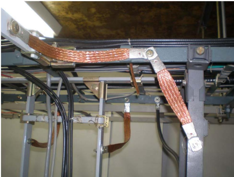
Figura 25 - Cordoalhas de cobre garantindo a continuidade elétrica das esteiras de sustentação
