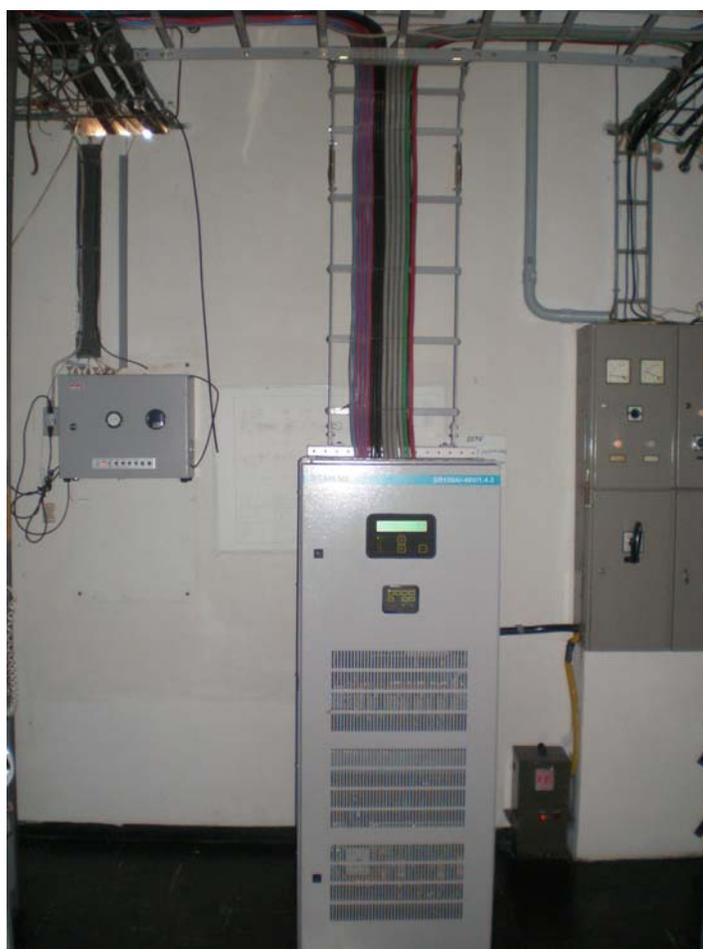
Figura 24 - Detalhe da continuidade elétrica da esteira metálica interligada ao retificador da estação rádio
