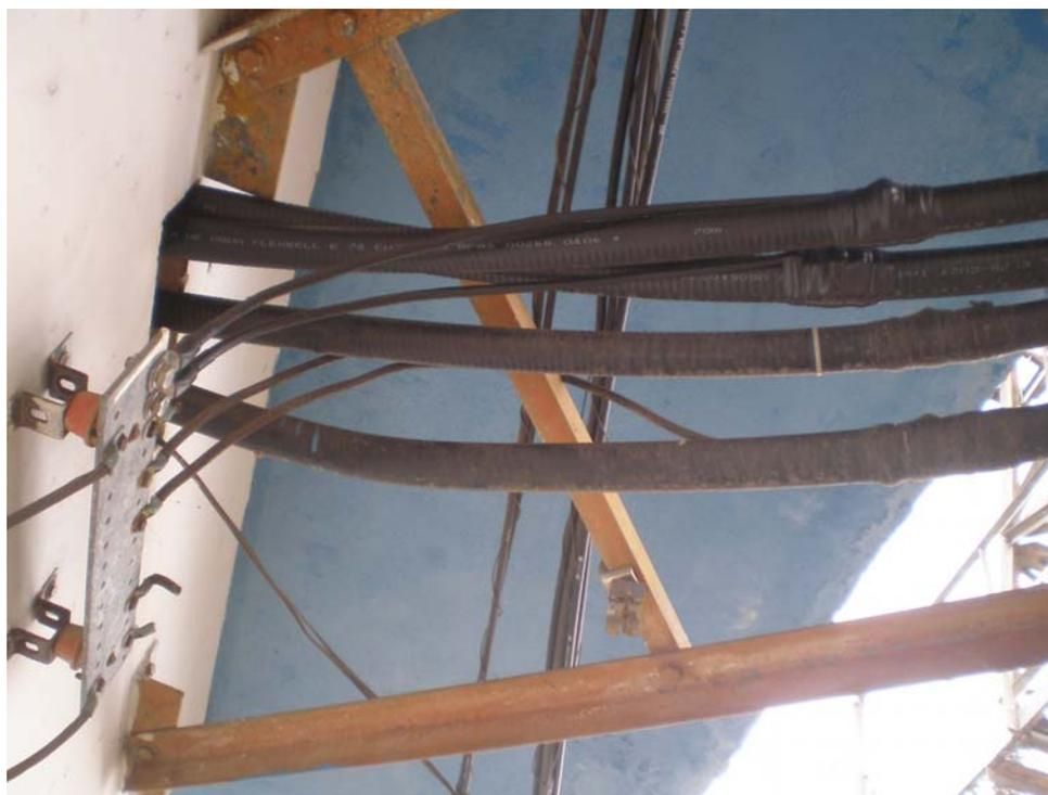
Figura 40 - Conexão da malha de revestimento dos cabos coaxiais ao sistema de aterramento da estação rádio
