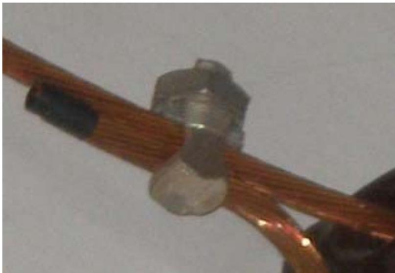
Figura 32 - Conexão da Gaiola de Faraday no teto da estação rádio
