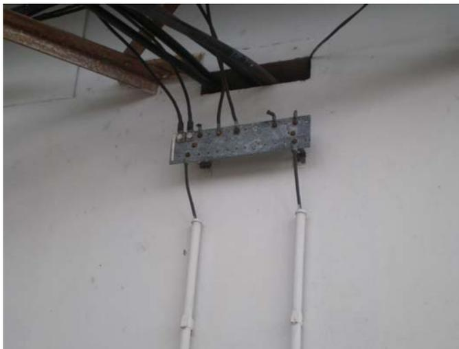
Figura 41 - Interligação da barra receptora da proteção dos cabos coaxiais à malha de terra
