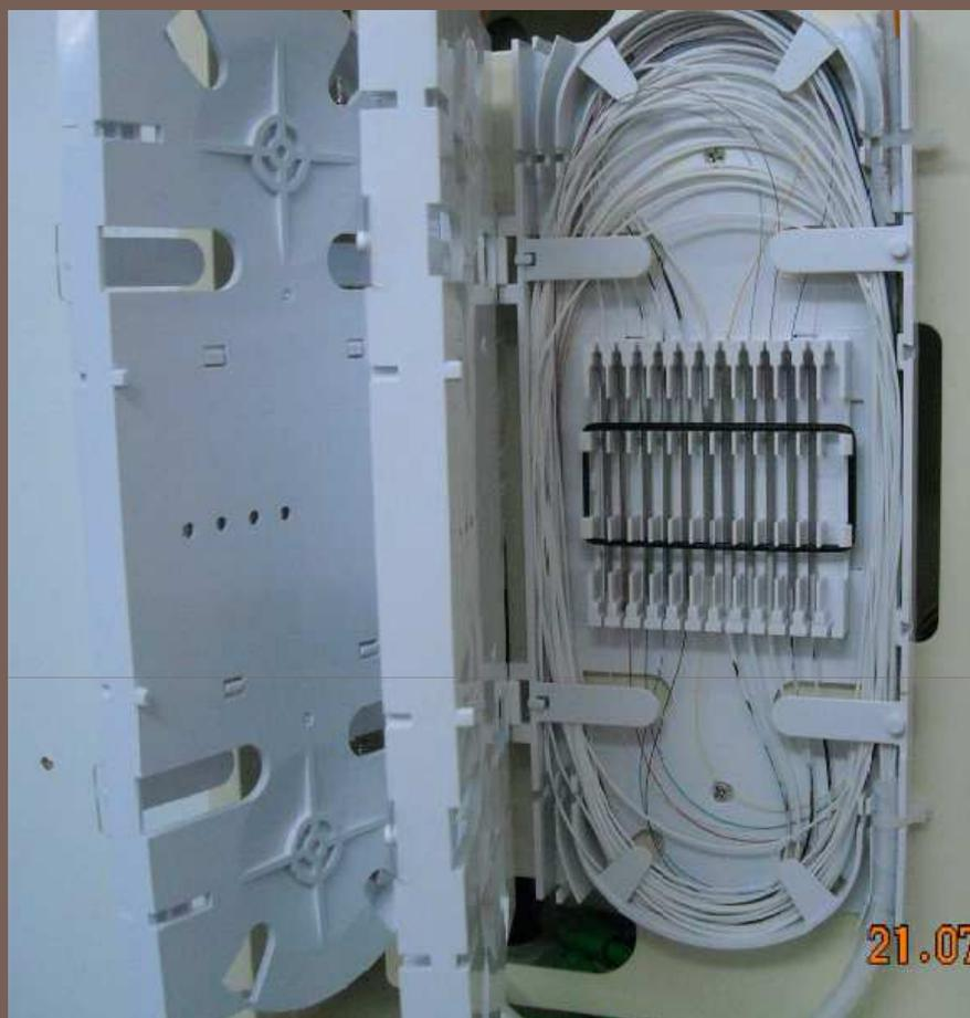
Caixa de piso com extracção de drops de cliente por fusão
