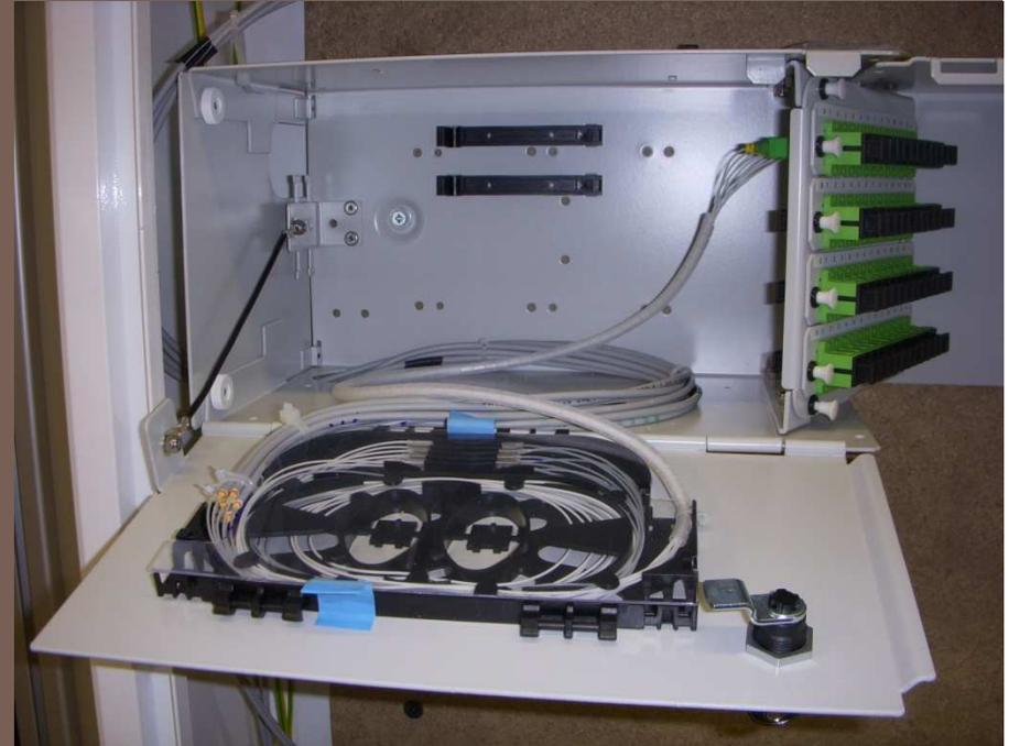
ATE com RGFO (secundário) . As fibras vindas das fracções são neste caso fusionadas com pigtais de conectores que ligam a adaptadores. Os Operadores ligam-se a estes adaptadores por cordões ópticos com origem nas suas caixas de distribuição óptica
