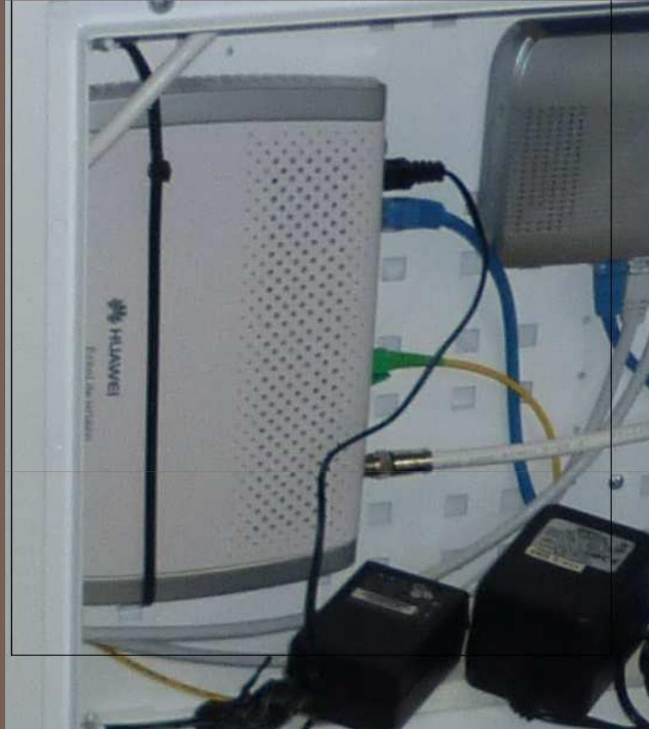
Caixa de apoio ao ATI (CATI) com ONT e Router IPTV onde se vê a chegada da fibra, a saída de RF (TV analógica) e ligação por patchcord UTP a Router IPTV com saídas para TV, Internet e Telefone
