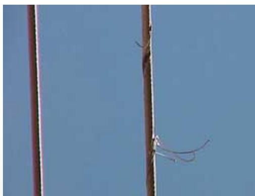
Figura 8.1.2.3 - Defeito ocasionado pelo efeito corona em uma linha de 345 kV.
