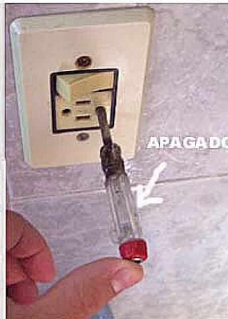
Executado este passo, **desligue a CHAVE GERAL da casa**, remova o espelho da tomada e a tomada em si e observe que existirão **2 fios conectados na parte traseira**, marque com algo o fio correspondente ao orifício que acendeu com a chave teste (fase ou positivo), e observe na figura a seguir que este fio deverá ficar segundo a ABNT ligado obrigatoriamente no orifício **direito** da tomada tripolar.
